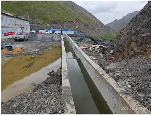
尾矿库混凝土截水沟及混凝土消力池（施工过程中）
