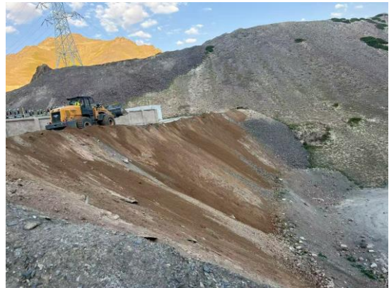
110kV 新建变电站边坡覆土撒草
