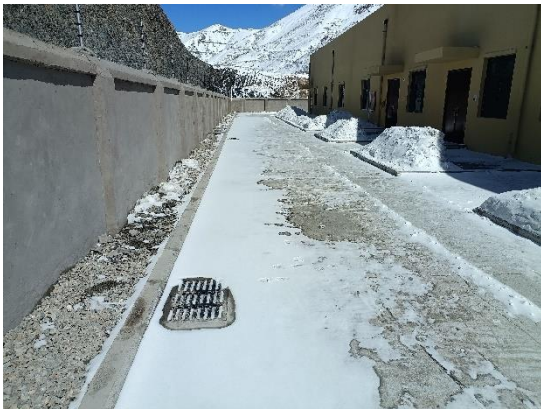
新建 110 千伏变电站排水暗管
