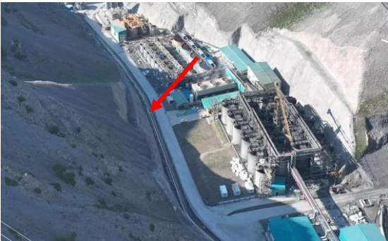
选矿工业场地钢筋混凝土排洪渠
