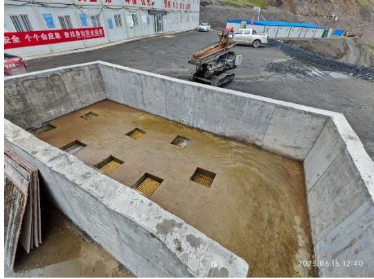
尾矿库混凝土截水沟及混凝土消力池（施工过程中）
