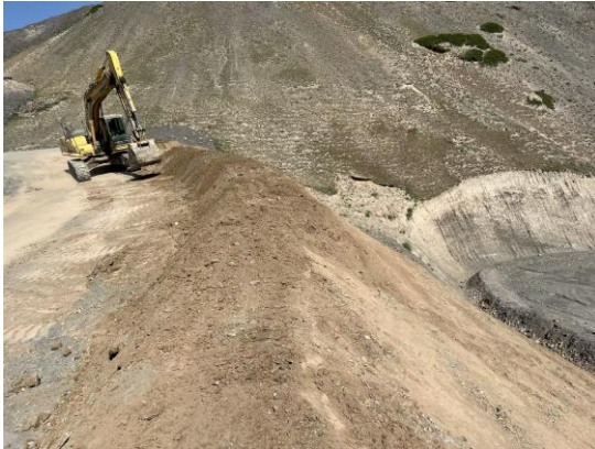
110kV 新建变电站边坡覆土撒草
