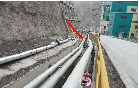
选矿工业场地钢筋混凝土排洪渠
