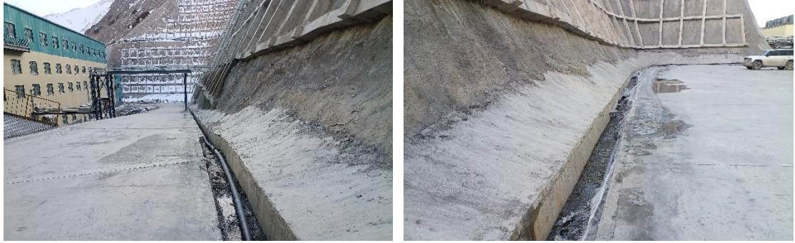
选矿工业场地混凝土排水沟
